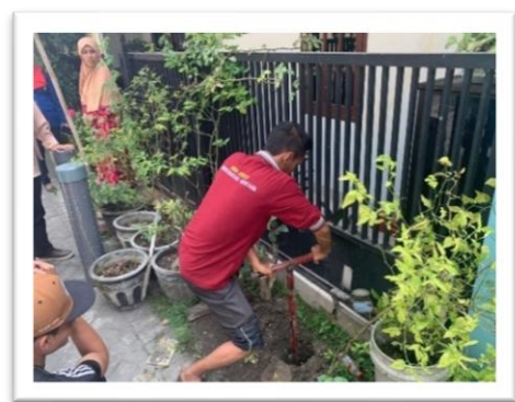
Gambar 4. Pembuatan Biopori
